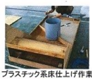
プラスチック系床仕上げ作業
